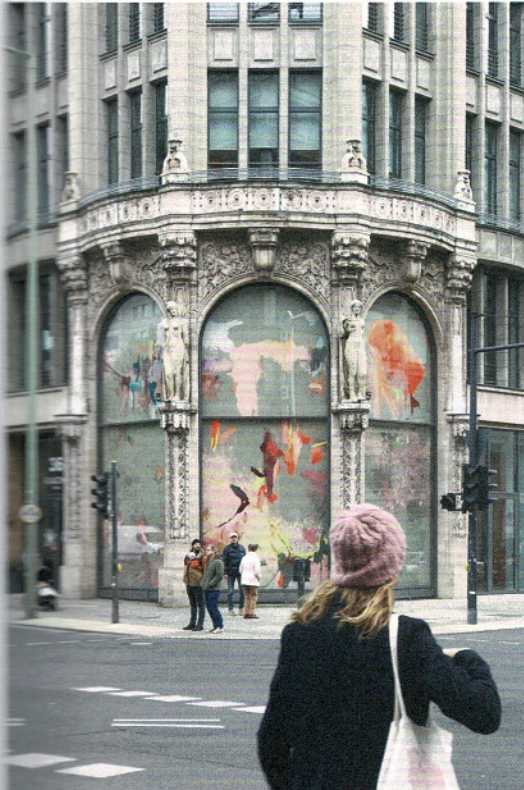
Das ehemalige „Damenmodehaus Kersten und Tuteur“ an der Leipziger Straße 36 wurde 1886 errichtet und erhielt sein heutiges Aussehen durch den Umbau des Architekten und Werkbundgründers Hermann Muthesius im Jahr 1913 und den erneuten Umbau durch Patzschke & Partner Architekten 2004.
