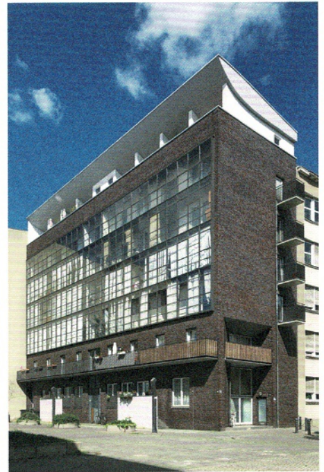
Charlottenburg: Wohnungsbau in der Eosanderstraße 18 von Hans Kollhoff, 1982 aus einem städtebaulichen Ideenwettbewerb des Senators für Stadtentwicklung und Umweltschutz hervorgegangen.
