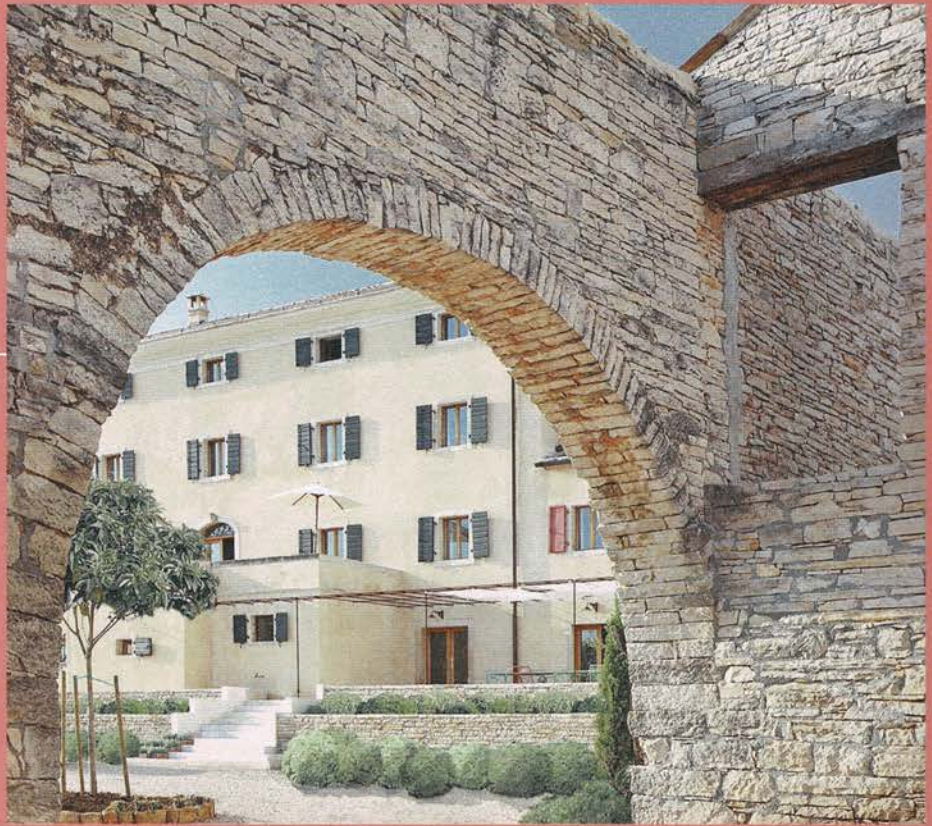
Wietersheim Architekten, Casa Ceppi, Istrien 2017. Das Haupthaus wurde komplett entkernt und durch eine Terrassenanlage aus altem und neuem Canfanar-Stein ergänzt. Foto: Wietersheim Architekten
