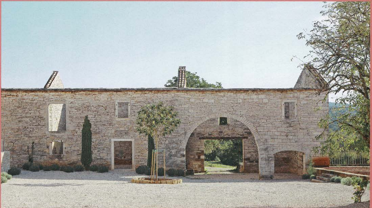
Wietersheim Architekten, Casa Ceppi, Istrien 2017. Der Seitenflügel wurde gesichert. Es entstanden markante Räume, die nach oben offen sind und im Sommer schattige Aufenthaltsbereiche sind. Foto: Wietersheim Architekten
